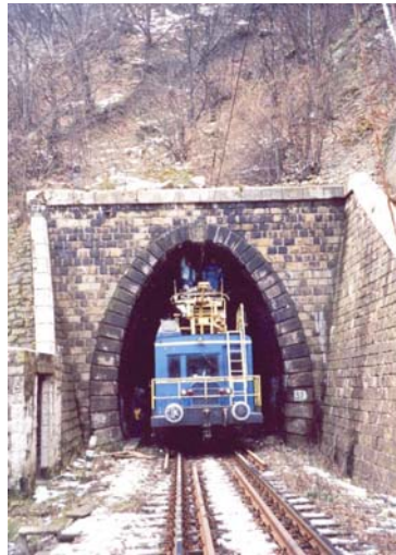
Obr.č.2 Portál na 112,58 km
