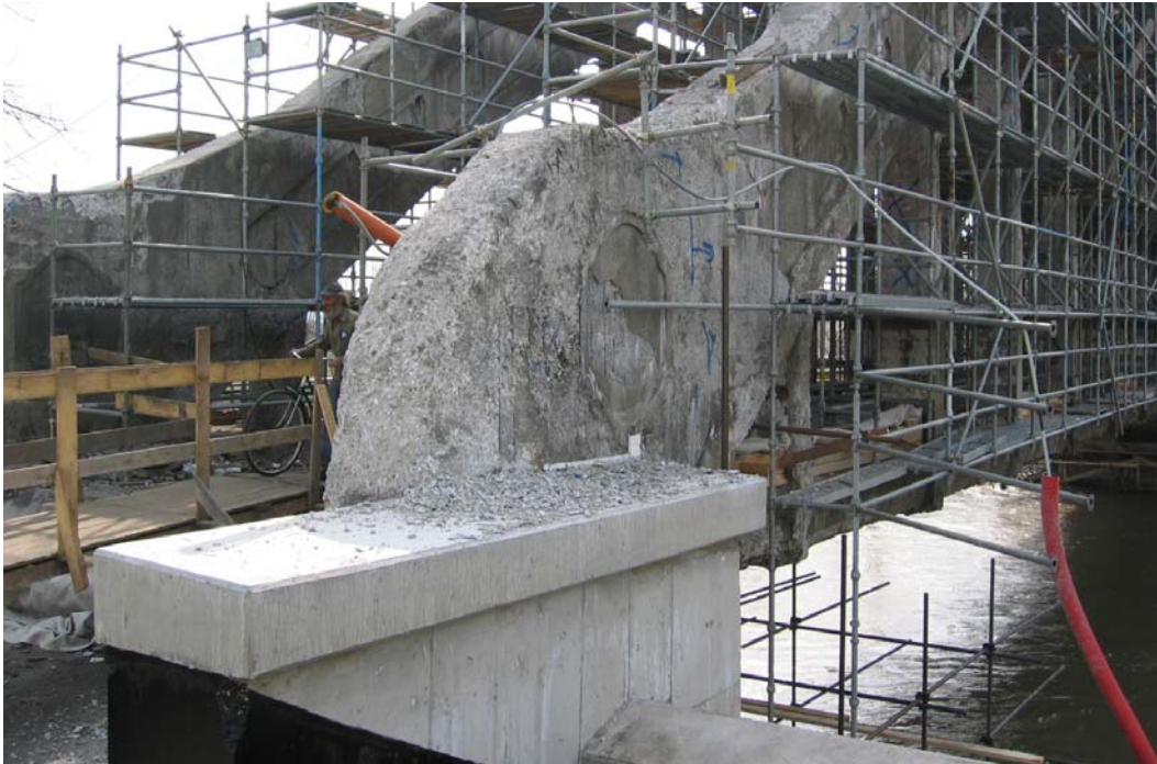
Obr.č.4 Názorná ukázka očištěné konstrukce
