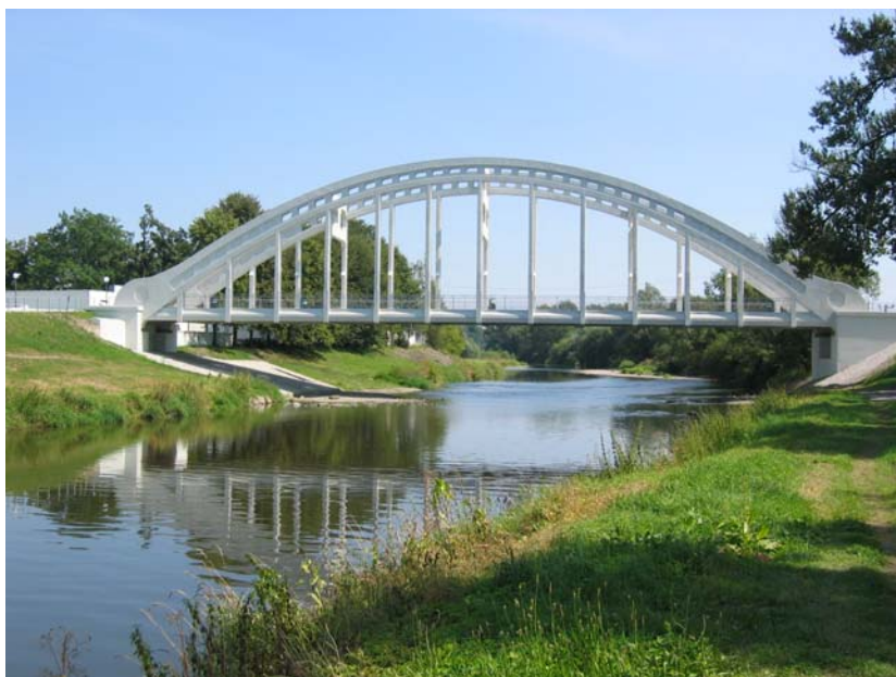
Obr.č.2 Dokončená sanace mostní konstrukce
