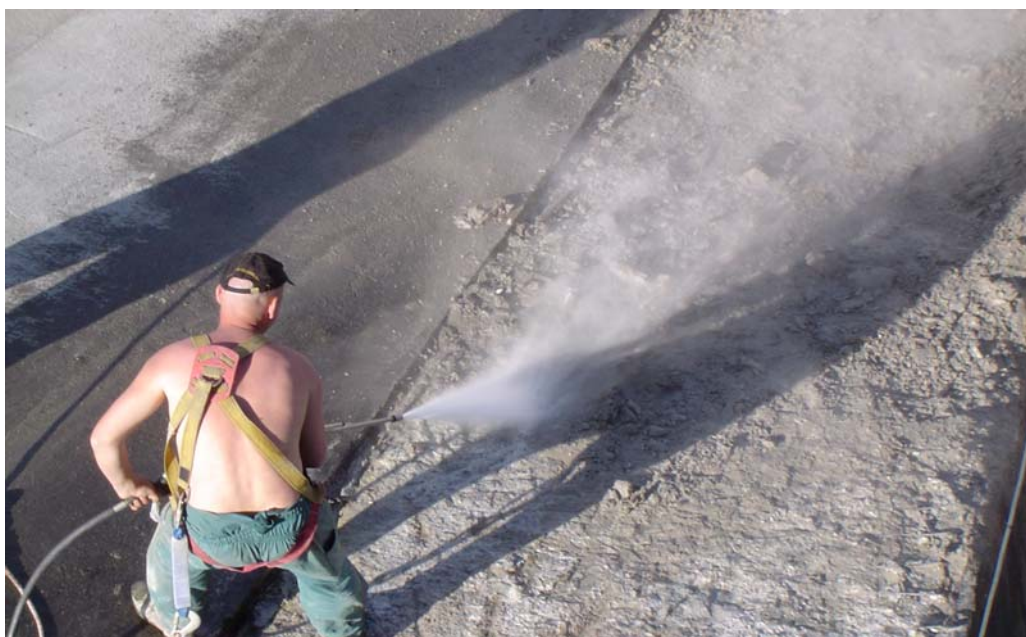
Obr.č.3 Otrýskání betonové plochy vysokotlakým vodním paprskem
