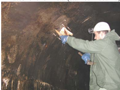
Přítok vody je utěšněn – odstraňování pomocných dřevěných klínek
