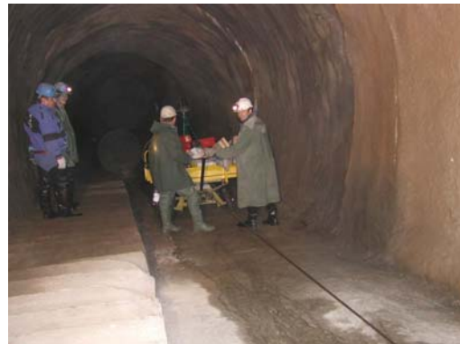
Doprava materiálů a zařízení úpadnicí
