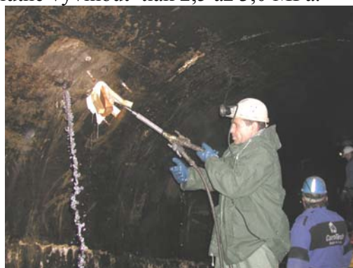
Postupná injektáž – omezování přítoku
