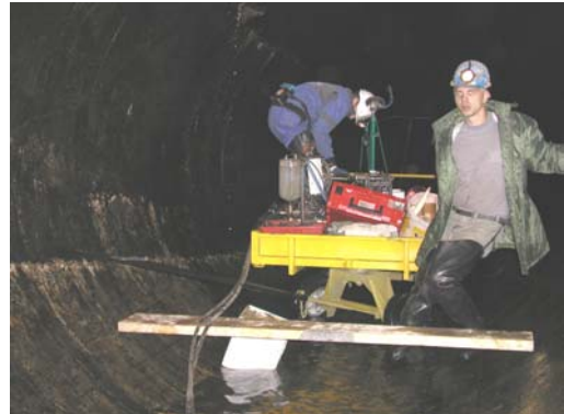
Vše potřebné je uloženo a dopravováno v záchytné vaně
