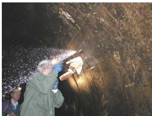
Postupné utěšňování přítoku voda právě stříká z odlehčovacího vrtu
