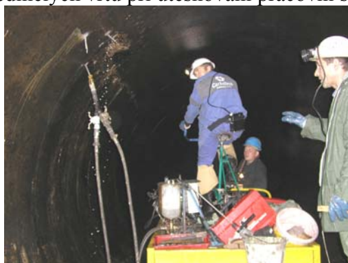
Injekční sestava – úsměvný cyklopohon, Čerpadlo DV 97, injekční hadice a pistole
