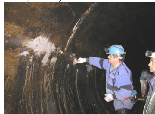
Úspěšný výsledek práce – přítoky jsou utěšněny injekční vrty jsou zapraveny cementovou maltou
