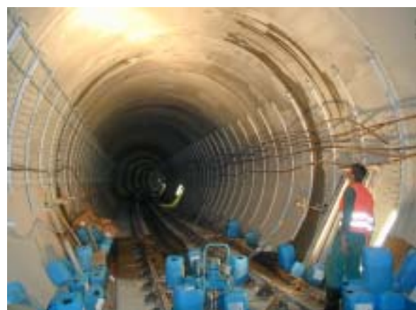
Celoplošná gelová injektáž jednokolejného tunelu
