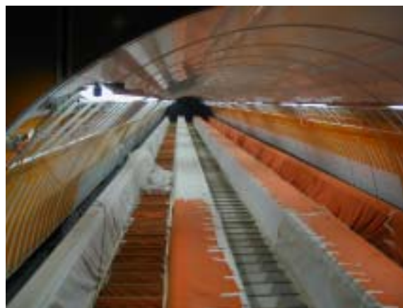
Po úplném zatěsnění mohou navazovat práce dokončovací
