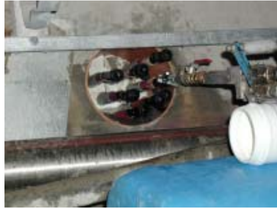
Napojení injektážní pistole do přírub
