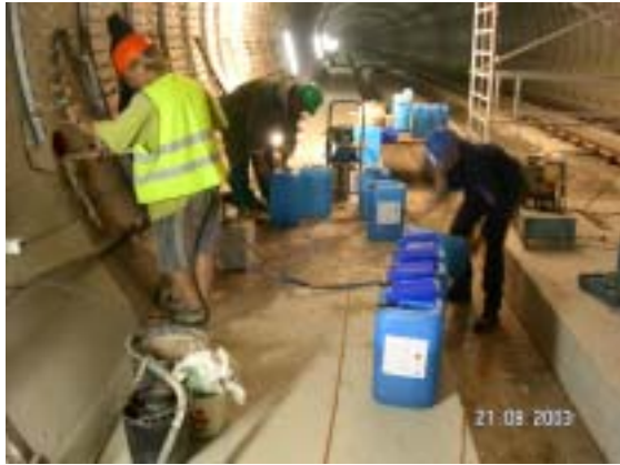
Injektáž sekce ve dvoukolejném tunelu
