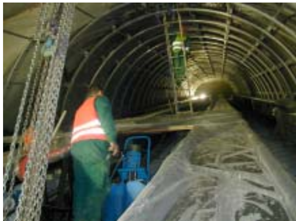
Gelová injektáž v místě napojení eskalátorového tunelu na stanici
