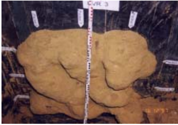
Obr.č. 5 – CarboCryl Hv – zkoušky provedení rubové izolace v propustných zeminách
