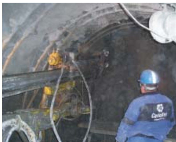
Průběh vrtání na čelbě díla
